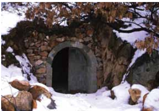
Vchod do štoly Király-bányák po rekonstrukci.
