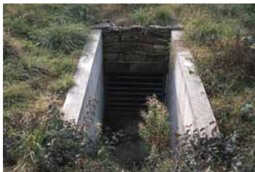
Malá štola ve svahu opatřená mříží, Velká Británie.
