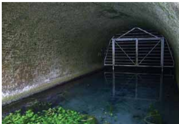
Mříž v ústí tunelu Greywell.
