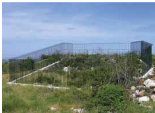
Oplocení vybudované kolem vchodu do významné štoly, Portugalsko.
