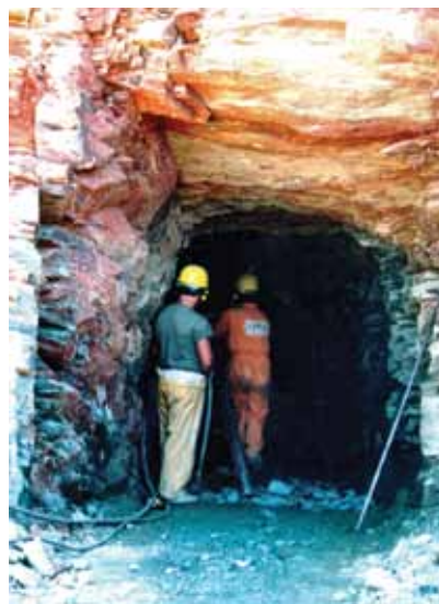
Hloubení umělé štoly Alqueva, Portugalsko
